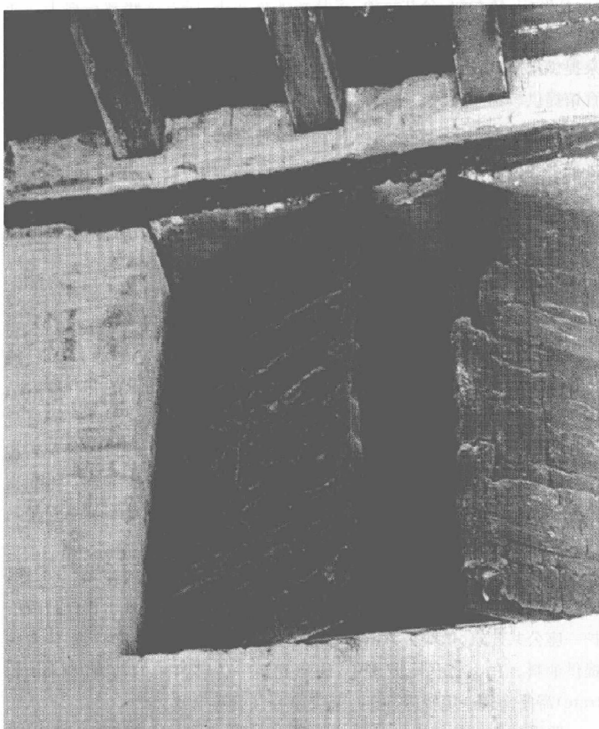
图 3.5 二楼窗户上的木制百叶窗,赫库兰尼姆,意大利。这扇二世纪的窗户能如此完好无损地保存下来,是由公元 79 年淹没整个城市的维苏威火山喷发的岩浆碳化的结果。
